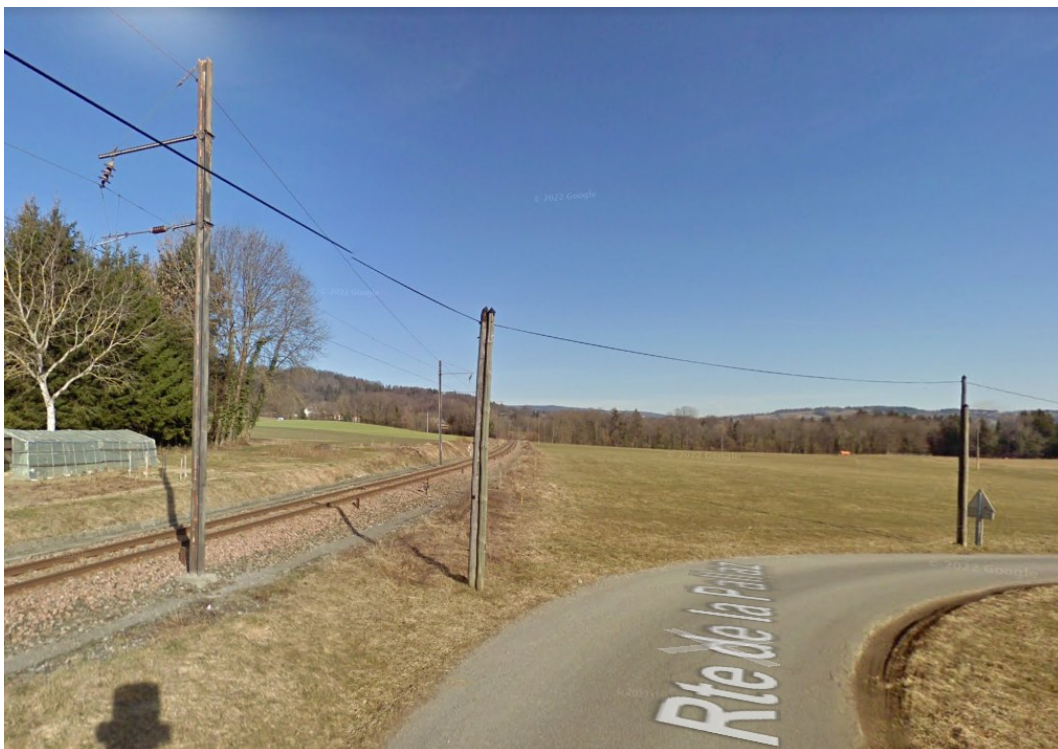
Illustration 289 : La voie en direction d'Aix-les-Bains (numéro 3 sur la photo de situation).
