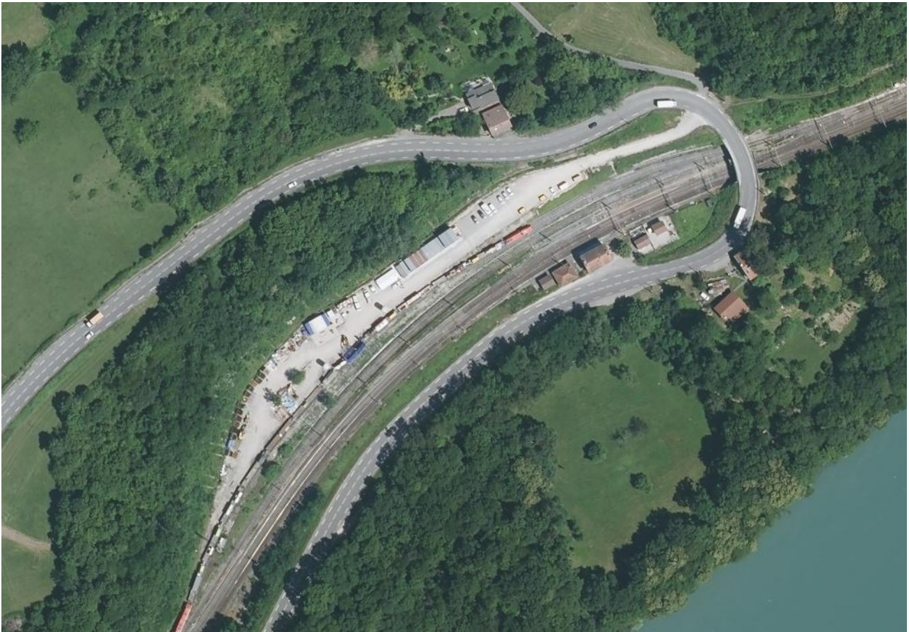
Illustration 339 : Vue aérienne de la gare désaffectée de Collonges Sud (G1). Coordonnées 46.127765, 5.909805.
