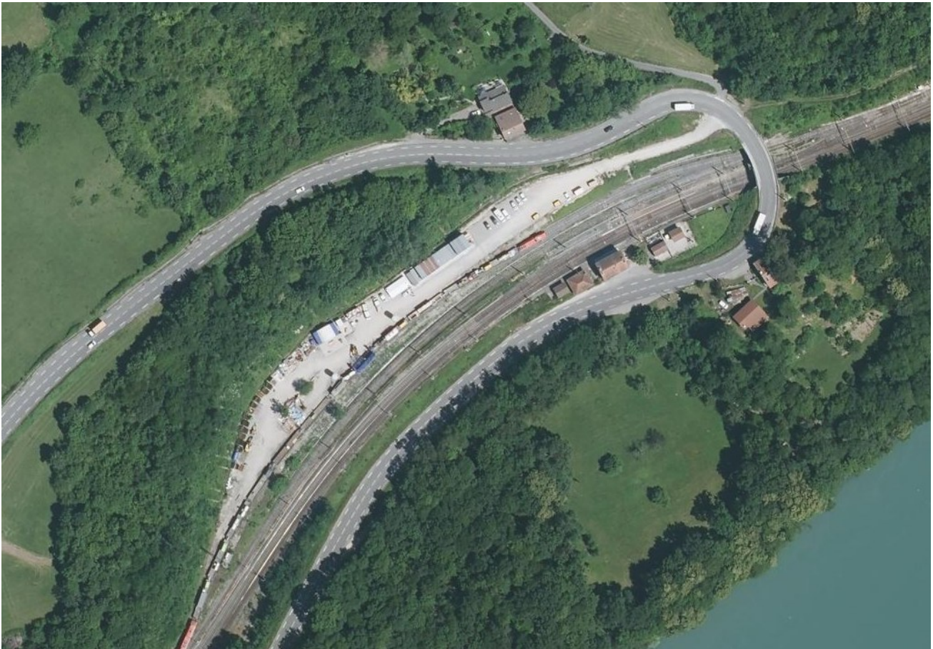
Illustration 368 : Vue aérienne de la gare de Collonges Sud. Coordonnées 46.127483, 5.909203.
