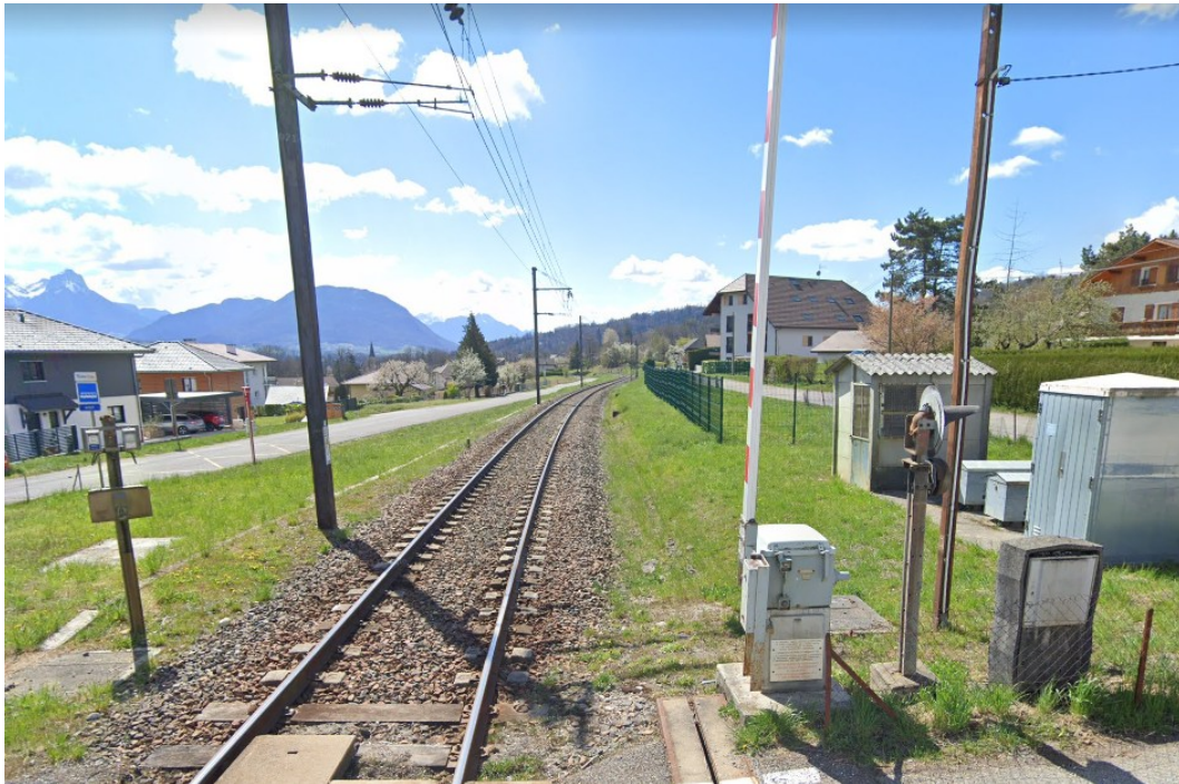
Illustration 290 : La voie en direction de La Roche-sur-Foron (numéro 4 sur la photo de situation).
