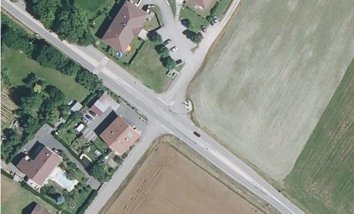
Illustration 235 : Vue aérienne du carrefour de connexion avec la RD1205. Coordonnées 46.150638, 6.313643.
