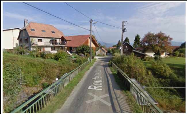
Pont qui franchit le chemin de fer (numéro 2 sur la carte de situation).
