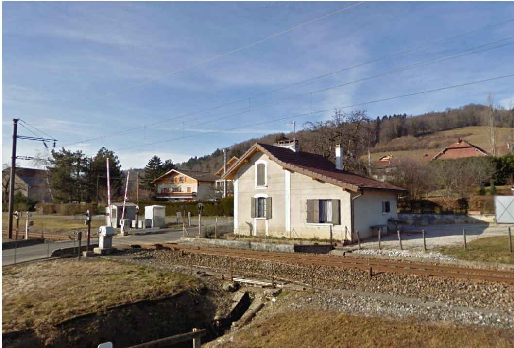
Illustration 288 : Vue du bâtiment du garde-barrière de l'ancienne gare de Charvonnex (numéro 2 sur la photo de situation).
