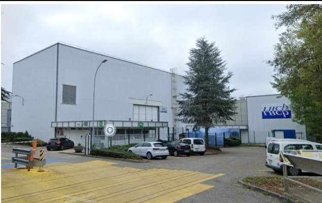
Site existant du CERN (numéro 3 sur l'Illustration 166)
