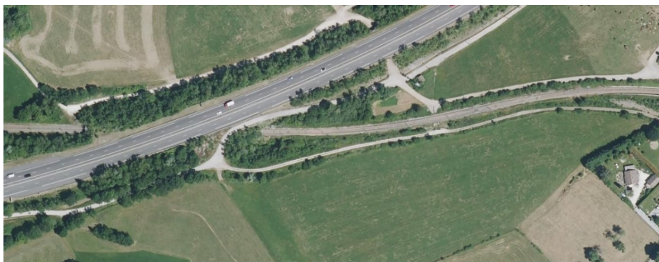
Illustration 261 : Vue aérienne du passage de la voie ferrée sous l'autoroute. Coordonnées 46.048134, 6.283501.
