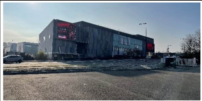
Centre commercial à proximité du site (numéro 2 sur l'Illustration 166)
