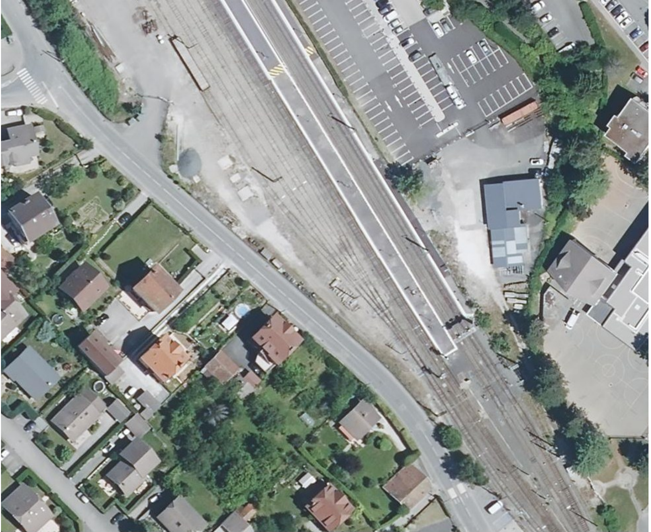
Illustration 221 : Vue aérienne de la gare de La Roche-sur-Foron. Coordonnées 46.067528, 6.303691.
